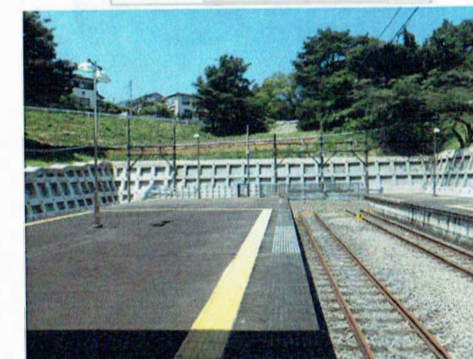
復旧完了全景
