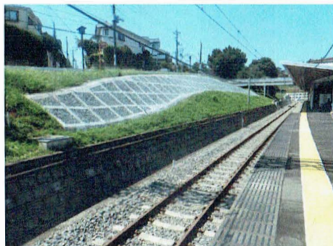
復旧完了全景
