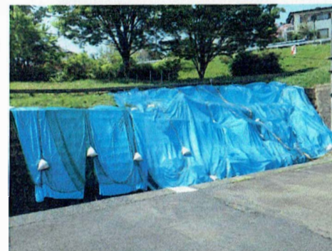
仮復旧完了時 ②
